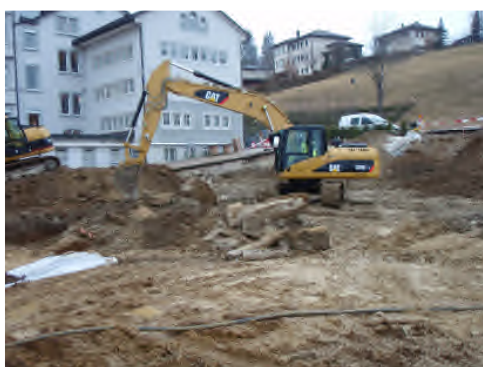
Tri des matériaux en continu et contrôle de l'envoi dans la décharge adéquate
