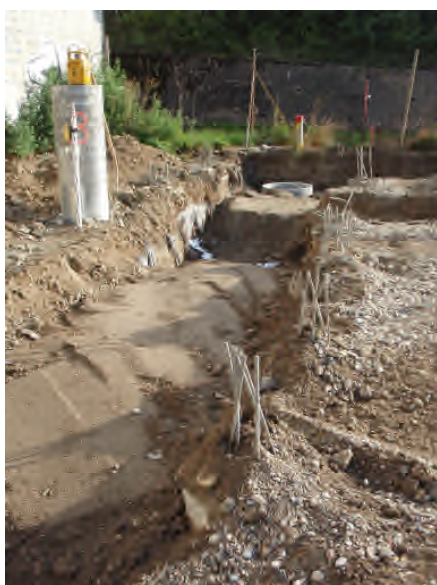
Réalisation des tranchées drainantes
