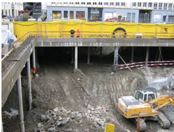
Terrassement et tri des matériaux en galerie taupée
