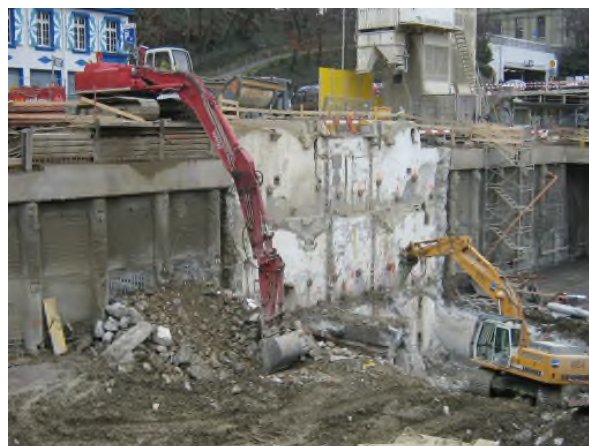
Tri en continu lors du terrassement
