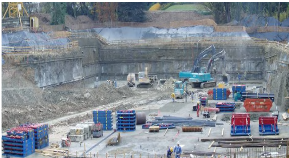
Vue générale paroi dans les alluvions avec nappe phréatique
