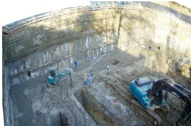
Vue paroi jetting clouée
