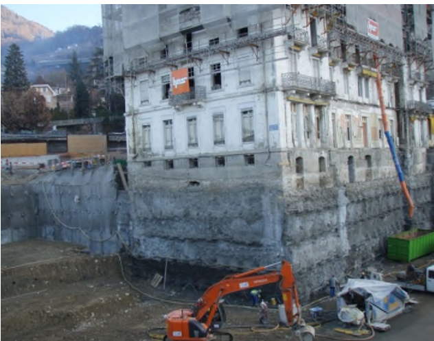
Reprise des efforts de l'hôtel National par un système de colonnes injectées directement sous les fondations.
