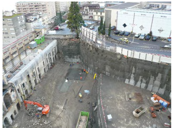
Parois berlinoises ancrées sous l'avenue des Planches
